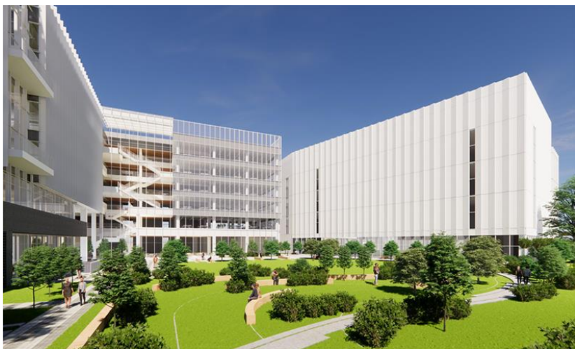
▲ 과천 신사옥과 데이터센터 조감도 (과천 지식정보타운 내)
