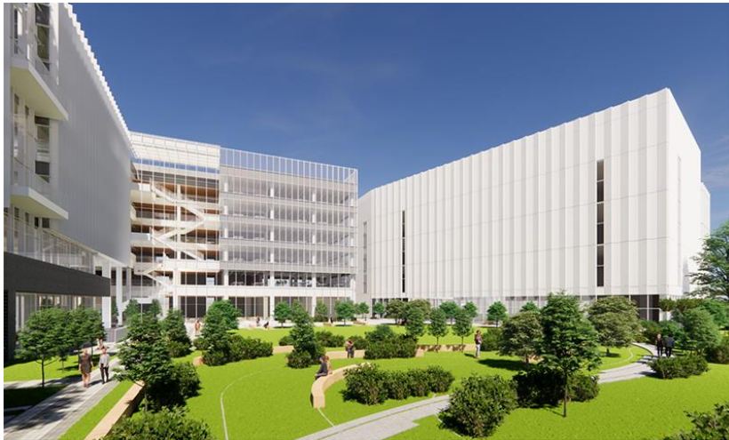
▲ 과천 신사옥과 데이터센터 조감도 (과천 지식정보타운 내)
